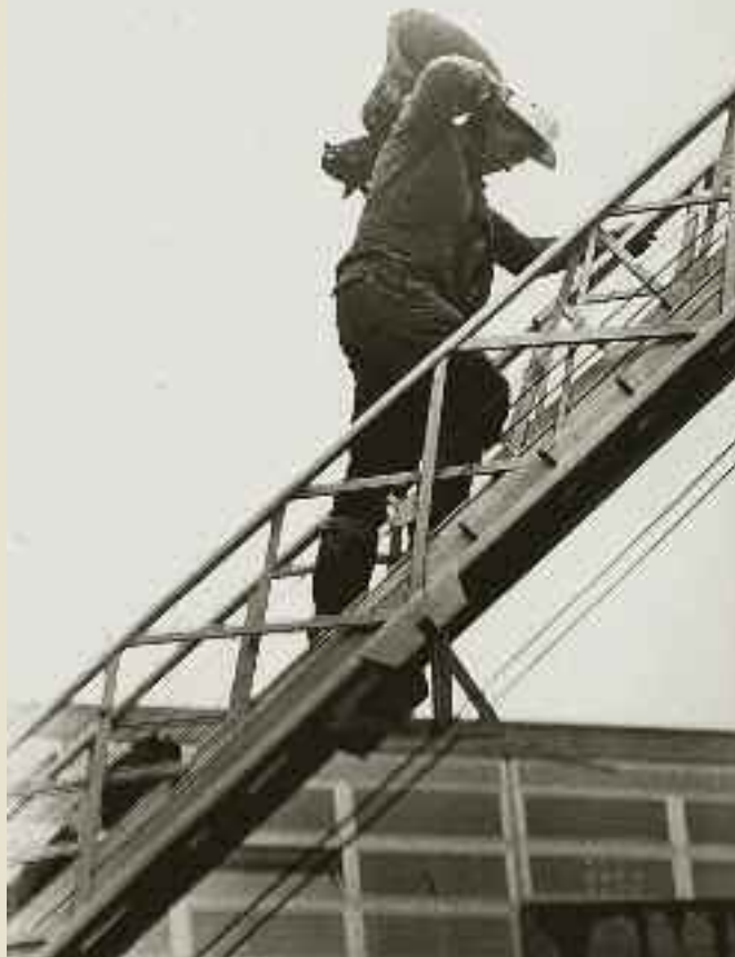
Vor dem Abbruch der alten Kapelle werden die Glocken aus dem Dachreiter geborgen
