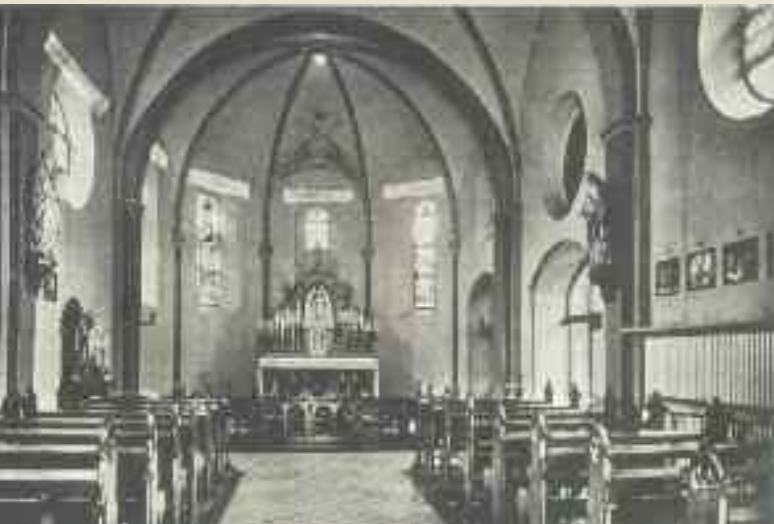
Das Innere nach der Renovierung 1937/38
